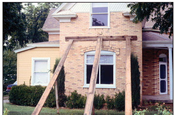
Refuerzo de una casa de mampostería no reforzada dañada por el terremoto de St. George de 1992. Se pueden ver grietas entre las ventanas del primer y segundo piso. Foto cortesía del Servicio Geológico de Utah.
