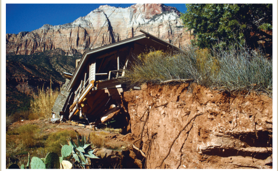
Casa destruida por el deslizamiento de tierra de Springdale, provocado por el terremoto de St. George del 2 de septiembre de 1992, M 5.5 . Foto cortesía del Servicio Geológico de Utah.
