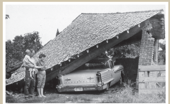
El movimiento del suelo por el terremoto de Richmond de 1962 M 5.8 , causó que este garaje de ladrillos se derrumbara sobre un automóvil. Foto cortesía de The Ogden Standard Examiner.
