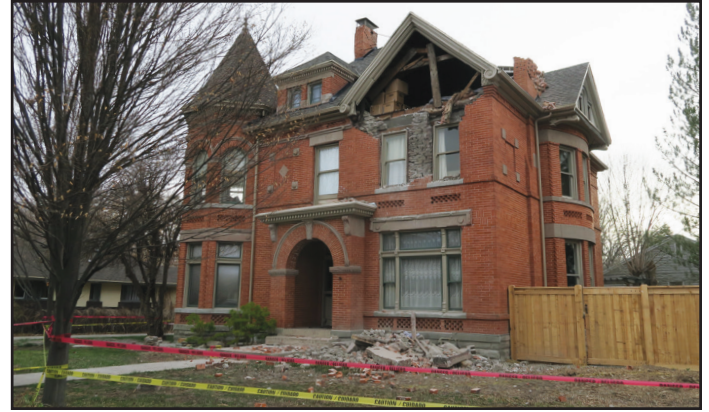
Daños estructurales por el movimiento del terreno en la histórica Mansión Sears en Salt Lake City. Esta casa fue demolida posteriormente debido a los extensos daños. Foto cortesía del Servicio Geológico de Utah.
